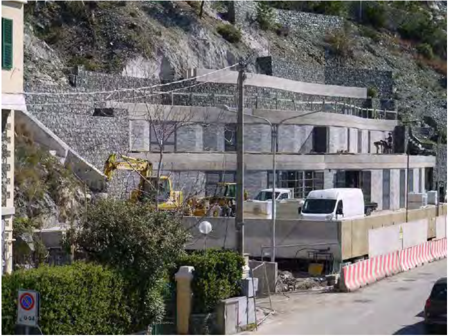
Fig.15 Il nuovo depuratore intercomunale di Levanto e Bonassola in costruzione (Foto di Patrizia Burlando)
