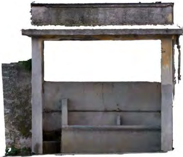
Fig.8 Genova, Lavatoio di via dei Molini a Nervi: fotopiano del prospetto principale del lavatoio. Le zone non raggiungibili, come ad esempio l'attacco tra copertura piana e serbatoio di accumulo, non sono state acquisite fotograficamente e quindi sono aree non rilevabili.
