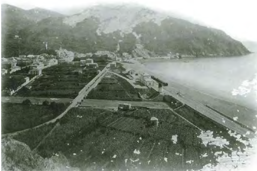
Fig. 4- Veduta di Levanto da Est, inizio '900 (Foto da F.Mazzino, 2006)
