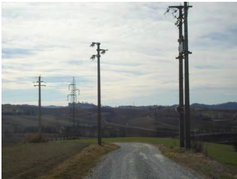
Elementi di forte disturbo
