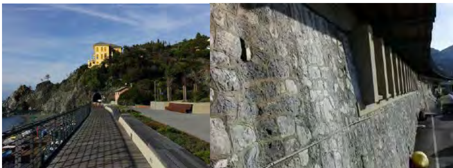
Figg. 10/11 Il nuovo waterfront (Foto di Mario Manfroni); Il recupero del rilevato storico 'sostruzione' del nuovo waterfront (Foto di Mario Manfroni)
