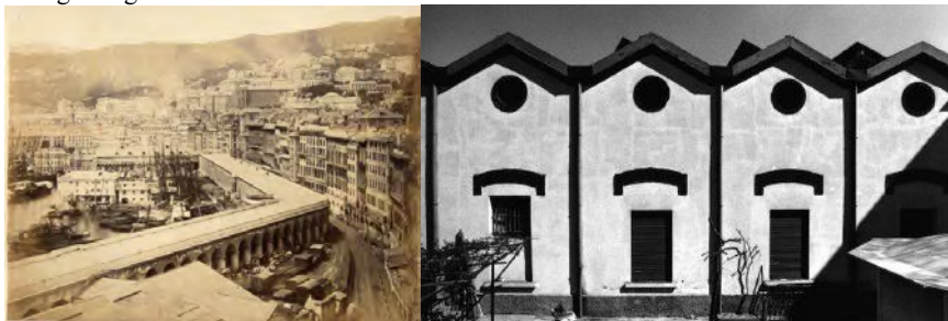
Fig.1 Alfred Noach (1833-1895), Genova, Piazza Caricamento con le terrazze di marmo demolite nel secolo scorso, per molti anni i genovesi non vedevano il mare. Il limite dentro la città.
